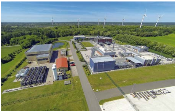
In Rüdersdorf hat EWE in einer Test-Kaverne die Wasserstoff-Speicherung untersucht. Foto: EWE
